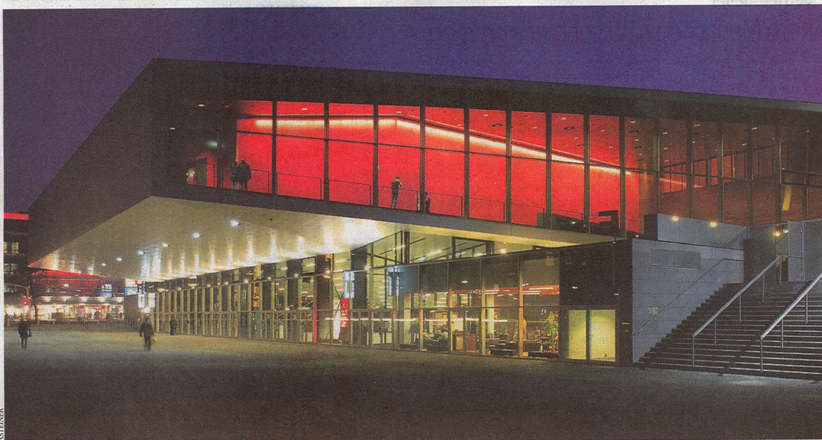
Die Fassade der Halle F der Wiener Stadthalle wird von Pasteiner als handwerkliches Meisterstück bewertet
